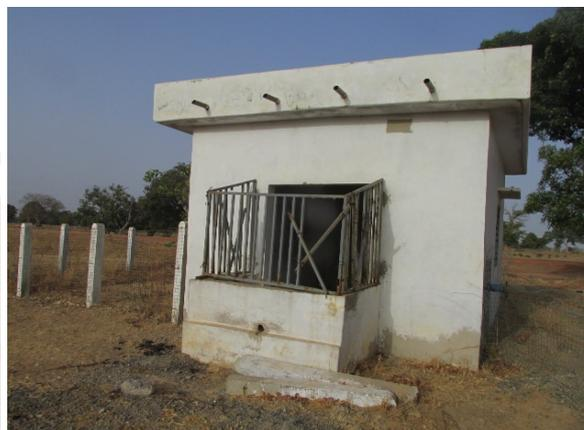
**Le périmètre du forage avec une dégradation du grillage et du fer**
